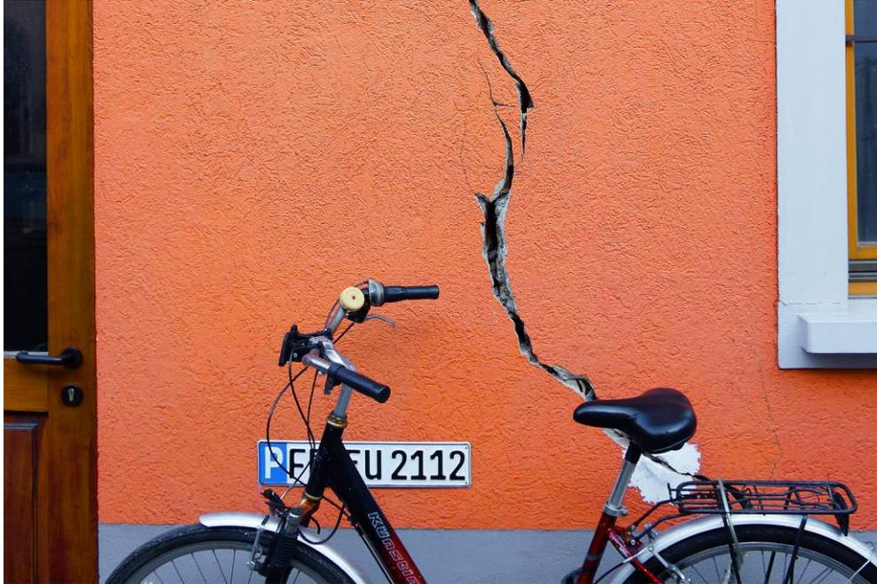
Abbildung 58: Schäden durch Anhebung der Erdoberfläche, Staufen, © Klaus Gebhard, Stuttgart
